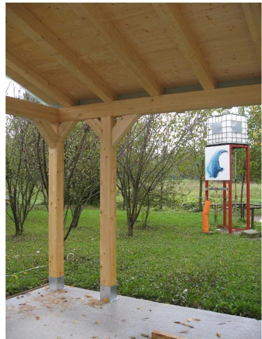
La parte più importante delle strutture portanti lignee utilizzate è l'attacco a terra su cordolo in C.A..
